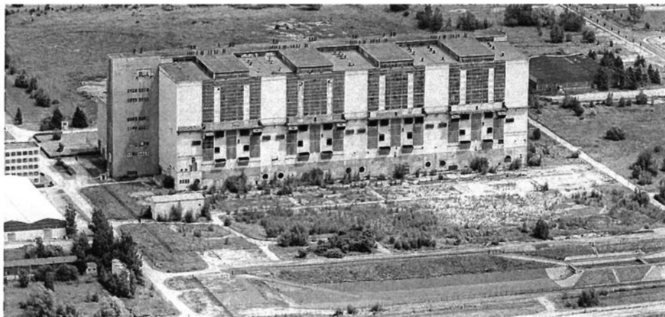
Das Gebäude des ehemaligen Kraftwerkes Thierbach aus der Vogelperspektive mit Blick auf das Kesselhaus. Von 1969 bis 1999 wurde hier Strom erzeugt. Jetzt wird der Komplex zurückgebaut, was voraussichtlich drei Jahre dauern wird. Foto: Jens Paul Taubert
