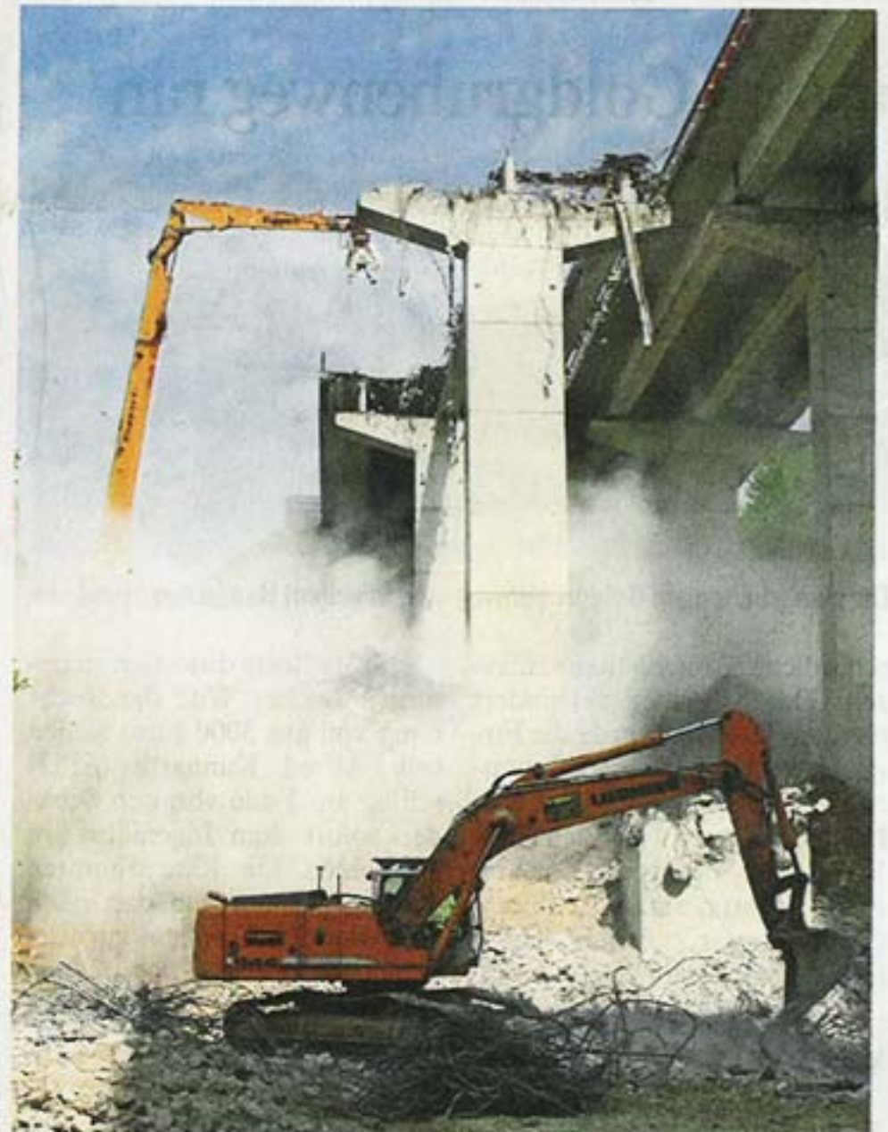
Eine große Staubwolke entsteht, wenn ein Träger auf den Boden kracht.
