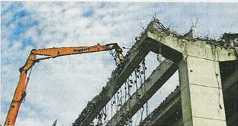
Stück für Stück nagt sich der Bagger durch den Beton.
