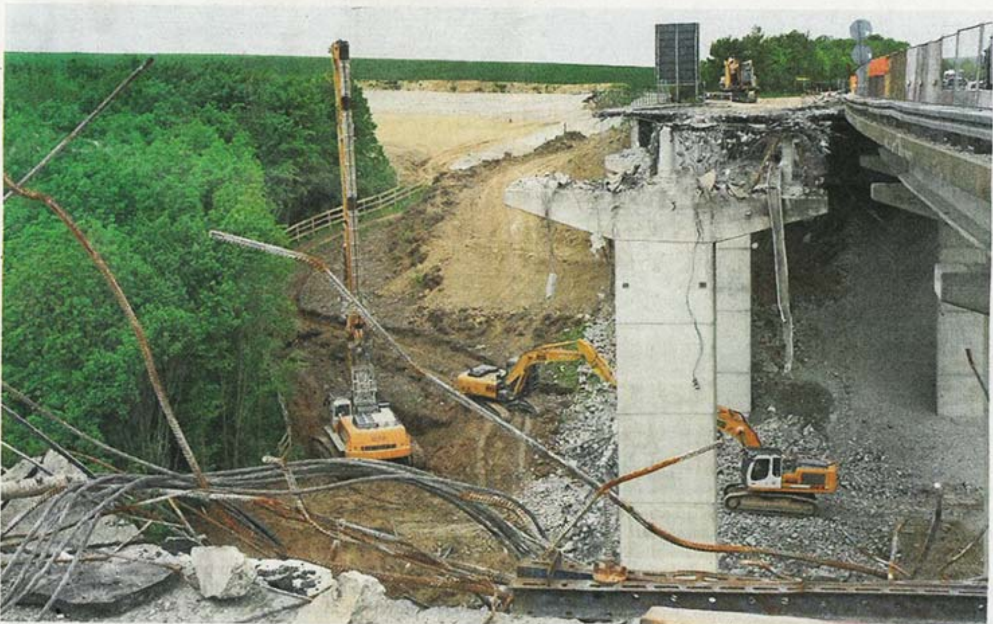
40 Meter geht es an der höchsten Stelle der Brücke nach unten ins Tal.
