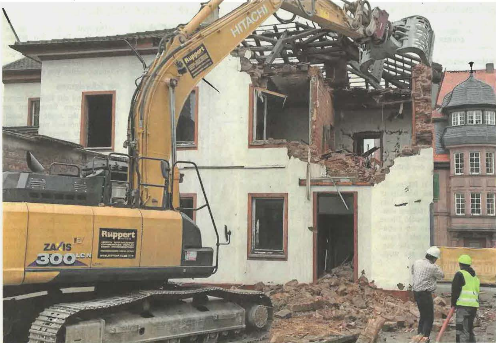
Ein Bagger frisst sich am Mittwoch in das ehemalige Verwaltungsgebäude der Lohrer Brauerei.
