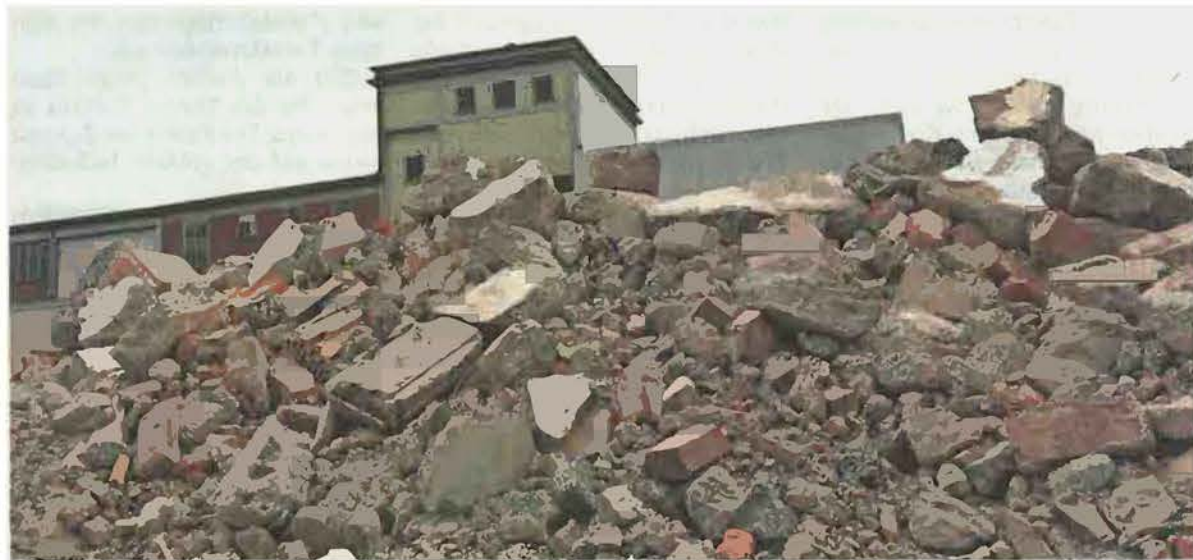
Etliche Schuttberge türmen sich derzeit auf dem Gelände der ehemaligen Brauerei im Lohrer Stadtkern. Rund 80 Prozent des Materials wird laut Abrissunternehmer Ruppert recycelt oder stofflich weiterverwertet.
