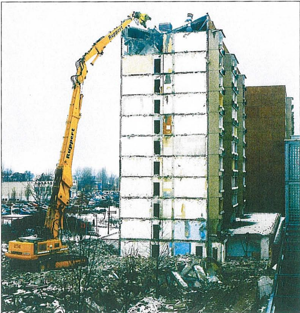
Atlas Copco Abbruchzange CC 3300 beim Abbruch von Plattenbauten in Hamburg
