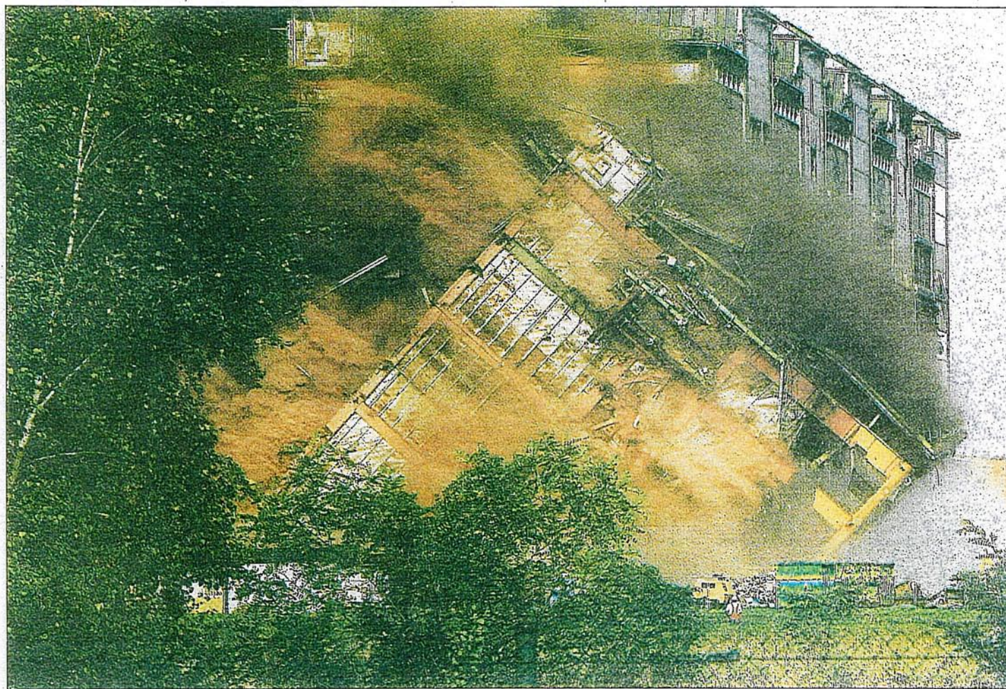
Der Kessel fällt: Gestern um 18 Uhr ist der erste Dampfkessel auf dem Lübbenauer Kraftwerksgelände gesprengt worden, fünf weitere werden folgen.
