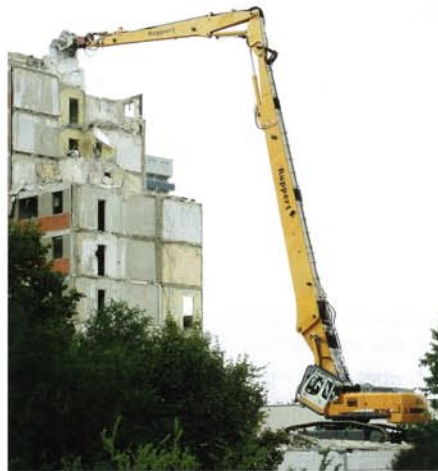
Ein Abbruchbagger leistet ganze Arbeit: Der R 974 C HD-EW beim Abriss eines Elfgeschossers in Plattenbauweise. (Foto: Liebherr)
