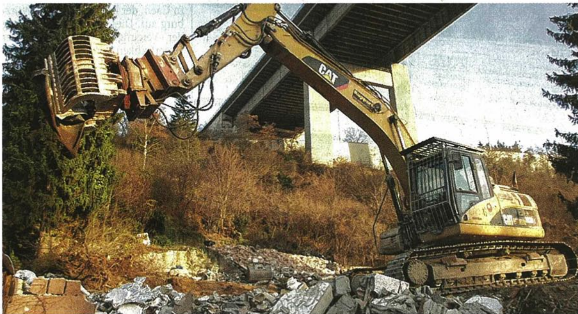
Abriss für die neue Brücke: Am Schattbergweg unter der A3 sind die Bagger im Einsatz.
